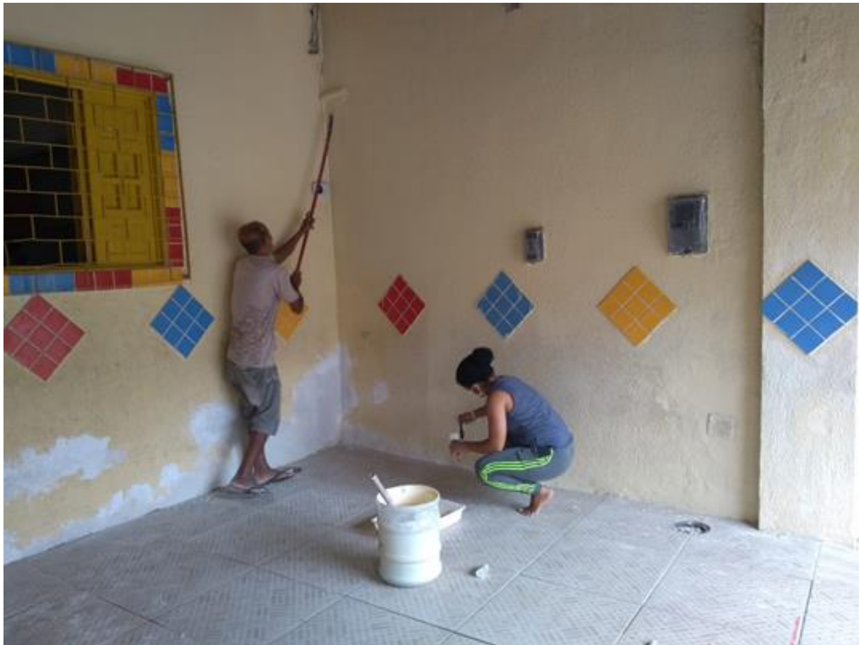
Neuanstrich im Eingangsbereich der Vorschule
